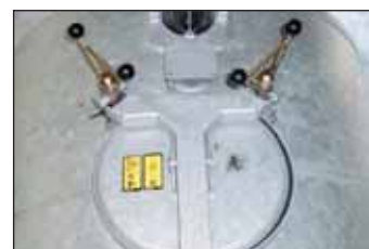
Bovenmangat (Ø 600 mm) op scharnier (optie)
